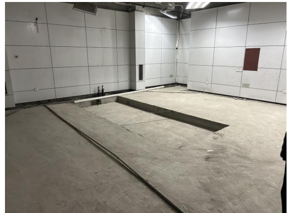
直线加速器机房现状
