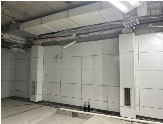
直线加速器机房现状
